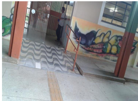
Figura 10 - Sinalização tátil de acesso ao pátio da escola EEU1
