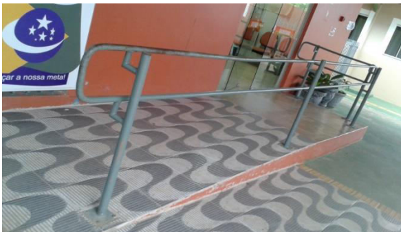
Figura 07 - Corrimão de acesso ao pátio da escola EEU1.
