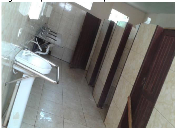
Figura 03 - portas acesso ao pátio EMU3
