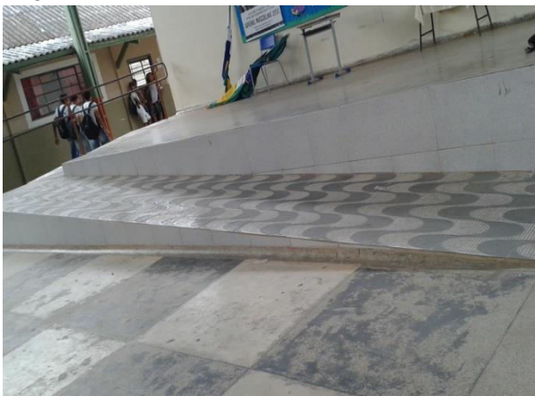
Figura 05 - Rampas de acesso ao pátio da escola EEU1
