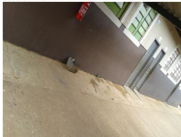
Figura 06 - Rampas de acesso as salas da escola EMU2.
