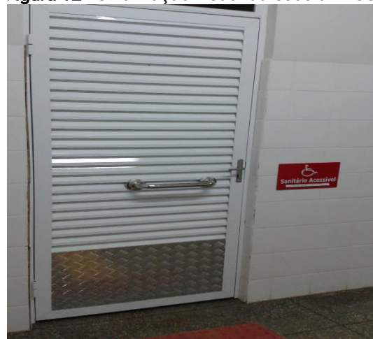
Figura 12 - Sinalização visual da escola EEU3
